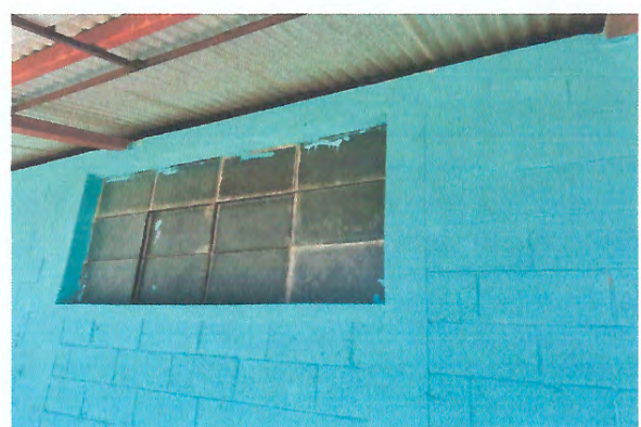
Foto 8: Mejoramiento de ventana (balcón)
