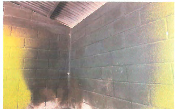
Foto 6: Mejoramiento de cocina (chimenea, pintura)
