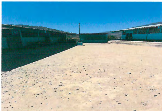
Foto 1: Remozamiento de loza de patio
