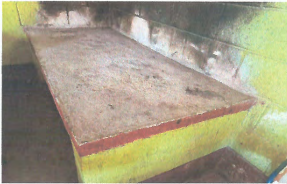
Foto 5: Mejoramiento de cocina (plancha de cocina, azulejo)
