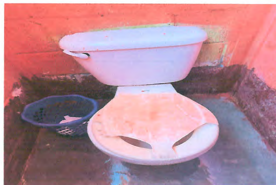
Foto 2: Mejoramiento de baños (cambio de sanitarios)
