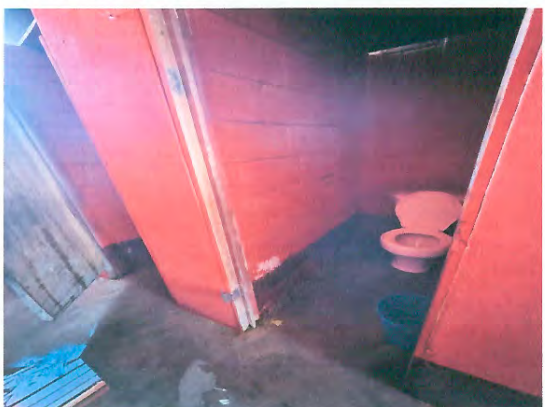
Foto 3: Mejoramiento de baños (puertas, pintura)
